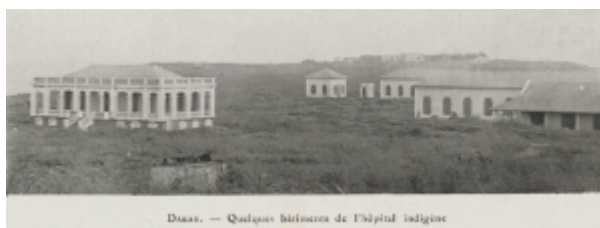
Figure 2 : Le dispensaire municipal et l'Hôpital indigène de Dakar en 1912 – Source : la Dépêche coloniale , 15 mars 1912
